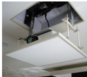
別途建築工事にて、架台補強工事が必要です。 天井化粧カバーは別途仕上げになります。
