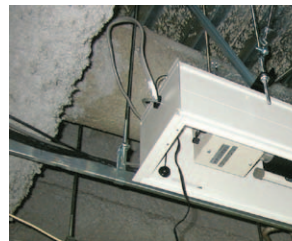
スラブから吊ボルトでALを固定
