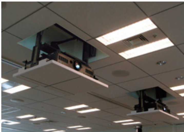
メンテナンスを考慮したロングストローク仕様。 パンタグラフタイプ(左)とワイヤータイプ(右)
