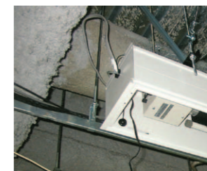
スラブから吊ボルトでALを固定
