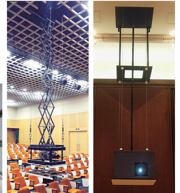
メンテナンスを考慮したロングストローク仕様。パンタグラフタイプ(左)とワイヤータイプ(右)
