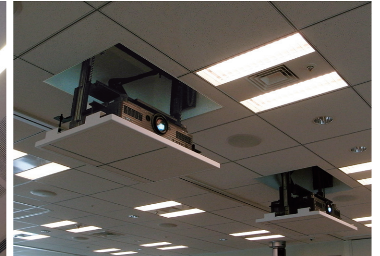
メンテナンスを考慮したロングストローク仕様。パンタグラフタイプ(左)とワイヤータイプ(右)
