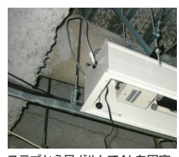
スラブから吊ボルトでALを固定
