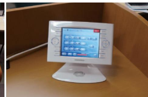
操作システムを見直し、タッチパネル操作に変更。不要な機材が入っていたラックは元々4連のものから2連へと変更。既存の音響設備はそのまま使用しつつ、スイッチャーなどの映像設備を主に更新しています。
