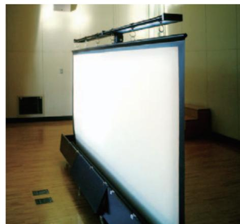
既設の大型バトンをスクリーンの引き上げに使用し、未使用時にはボックスに収納するスクリーン。
