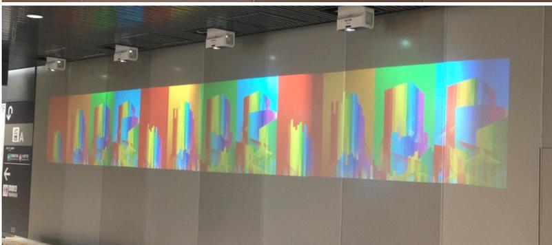
コンコースの壁面に超短焦点プロジェクターを使用して横幅10mのパノラマ映像を実現。壁面の凹凸による歪み補正とブレンディングを行っています。長時間にわたる運用でも遅延や停止することなく再生しています。
