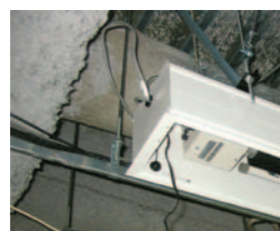
スラブから吊ボルトでALを固定
