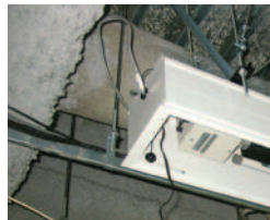
スラブから吊ボルトでALを固定
