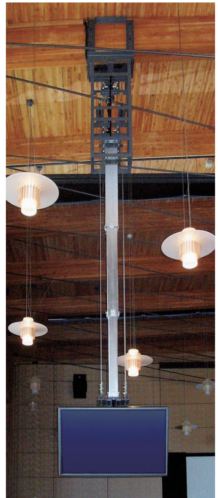
メンテナンスが楽な、高天井用のロングストローク
