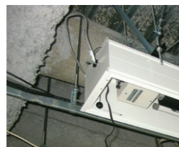
スラブから吊ボルトでALを固定
