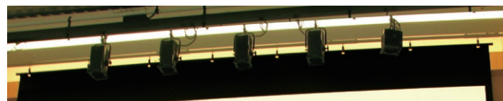
■多点吊のため高い平面性を確保
