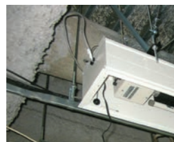
スラブから吊ボルトでALを固定
