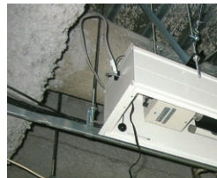
スラブから吊ボルトでALを固定
