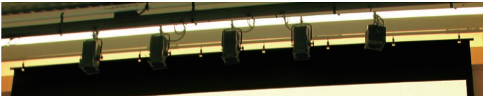
■多点吊のため高い平面性を確保
