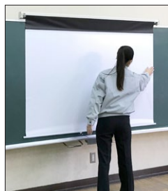
全体に浮きを確認し、設置完了です。
