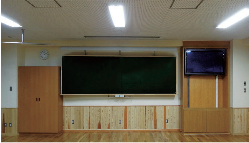
タッチパネルを使用するときには下げて、皆で見るときには上げる昇降機。静粛性と耐久性に優れた生地駆動を採用。
