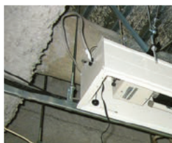
スラブから吊ボルトでALを固定
