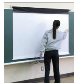
全体に浮きを確認し、設置完了です。
