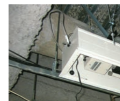
スラブから吊ボルトでALを固定
