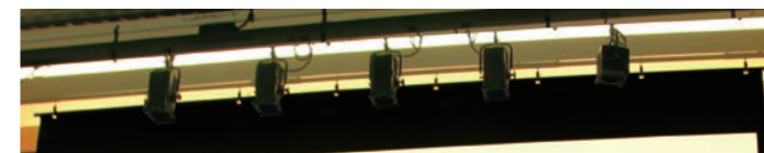
■多点吊のため高い平面性を確保
