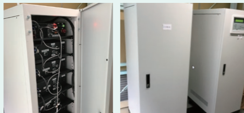
キャビネットにいれ、7直列接続することにより、30kVAの蓄電システムの構築ができます。
