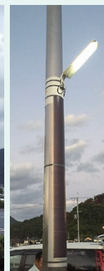
既設ポールへの設置
