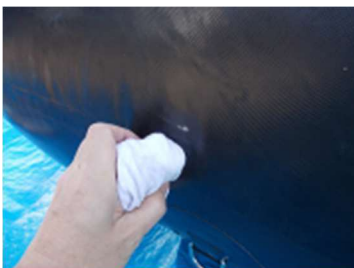
① 破損部の清掃
